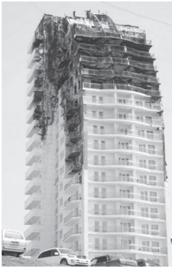
использованием для защиты утеплителя сгораемых влагозащитных мембран.
