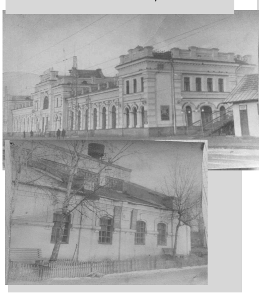
Здание вокзала и здание на вокзальной площади
