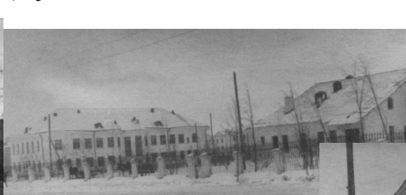
Центральная районная больница по ул. Маяковского
